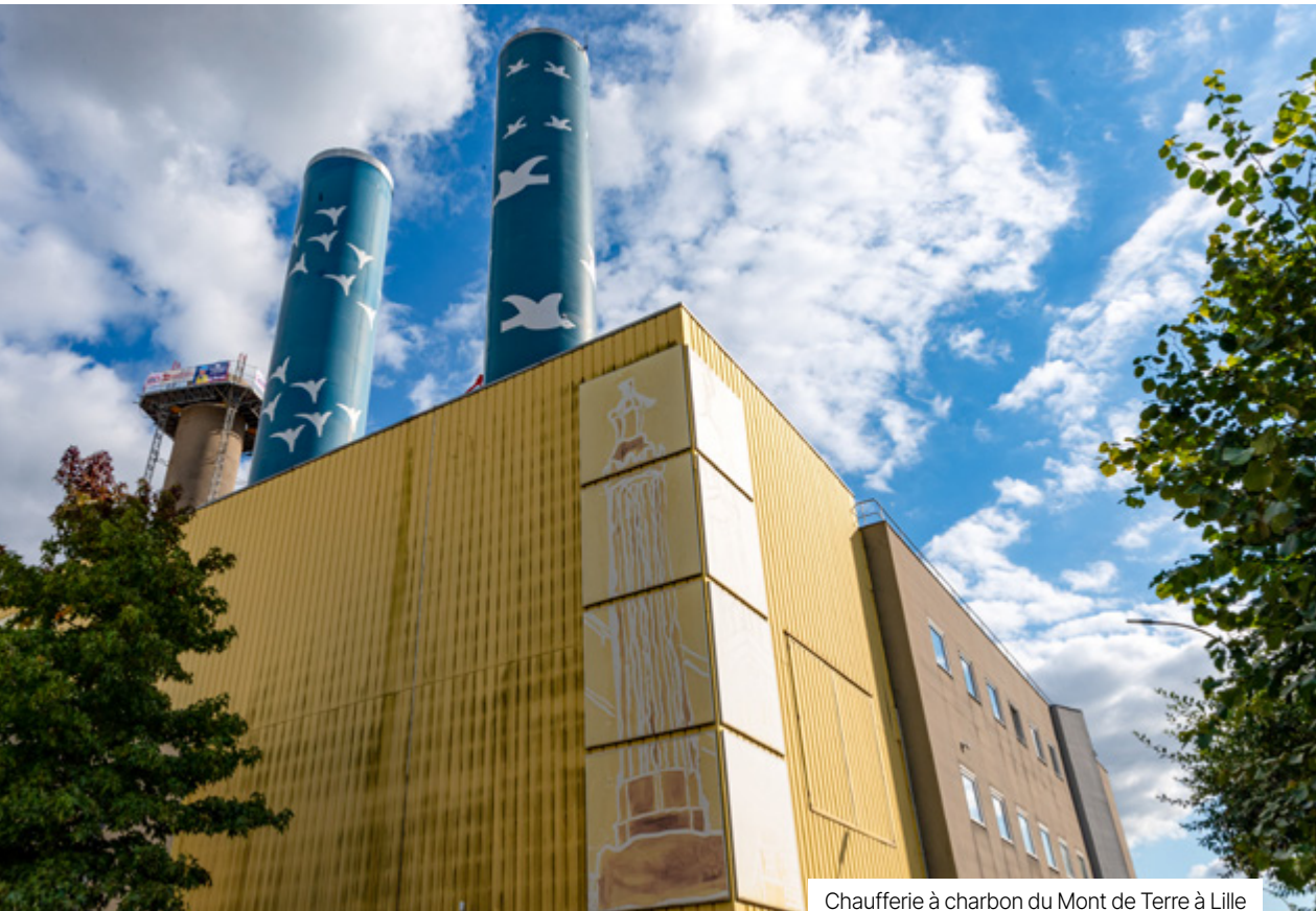
Chaudière à charbon du Mont de Terre à Lille
