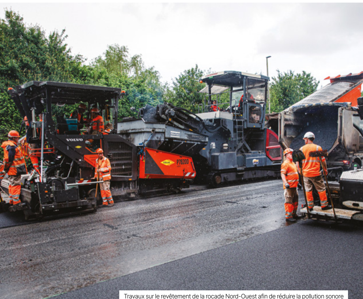
Travaux sur le revêtement de la rocade Nord-Ouest afin de réduire la pollution sonore
