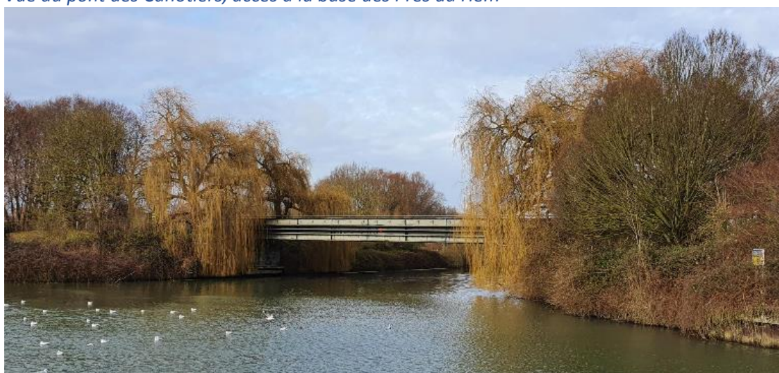
Vue du pont des Canotiers, accès à la base des Prés du Hem
