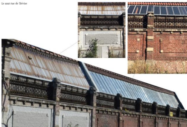
Le mur rue de Trévis
