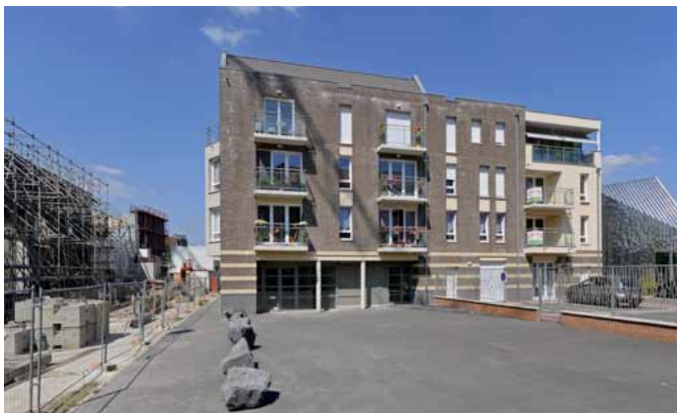
Armentières / Les Villas Lumière / Loger Habitat et Notre Logis
